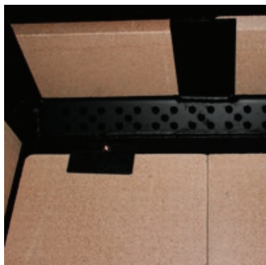
Vermiculite Innenraumauskleidung
