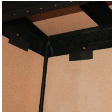
Brennraumauskleidung aus Vermiculite
