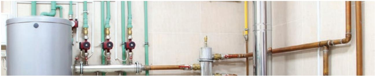
**Wenn Sie einen wasserführenden Kamineinsatz installieren, spielt die Wahl des Speichers eine besondere Rolle. Denn dieser ist für die Speicherung des Warmwassers verantwortlich. Ohne einen Speicher würde die erzeugte Energie verloren gehen und der besondere Vorteil eines wasserführenden Kamineinsatzes nicht genutzt werden.**
